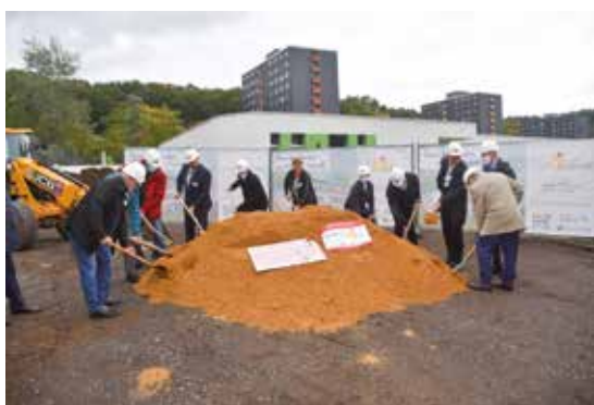
Zahlreiche Gäste helfen Ende September beim feierlichen Spatenstich für das Bauvorhaben.
