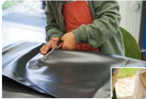
Die Kästen der Kräuterpalette werden mit Teichfolie ausgekleidet.
