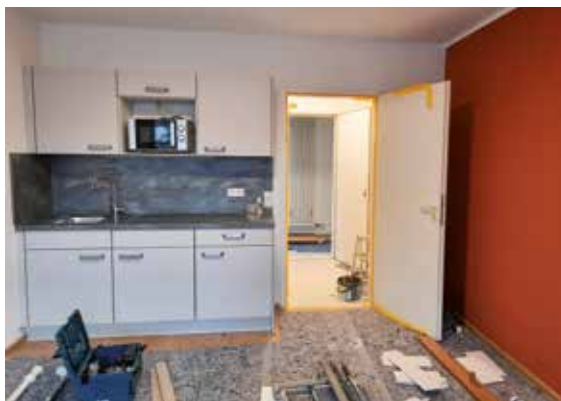
Das Familienzentrum in Frankfurt wird rundum saniert.
