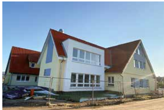
Die Lehrküche zieht in den neuen Anbau, der neben dem Haupthaus errichtet wurde.
